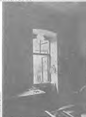
Prozor strojarnice iznutra: Iznad prozora odvaljen zid. Na polici vidi se nekoliko manjih dijelova bombe. Oklop bombe i oko 50 manjih komada predano je uz zahtjev policiji.
